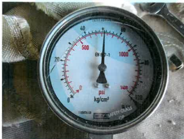
照片三 測試壓力 50.6 kgf/cm 2 Picture 3 Test Pressure 50.6 kgf/cm 2
