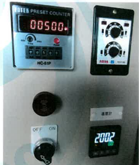
照片四 計數單元 Picture 4 Counter
